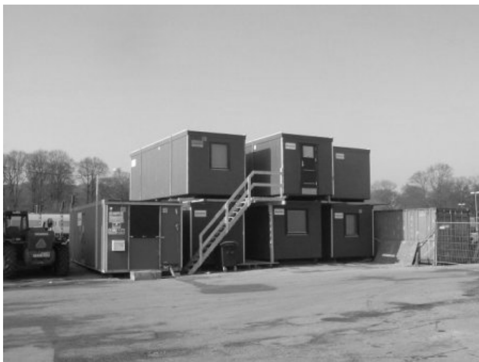
Figur 15-24: Skurvognopstilling på byggeplads.
