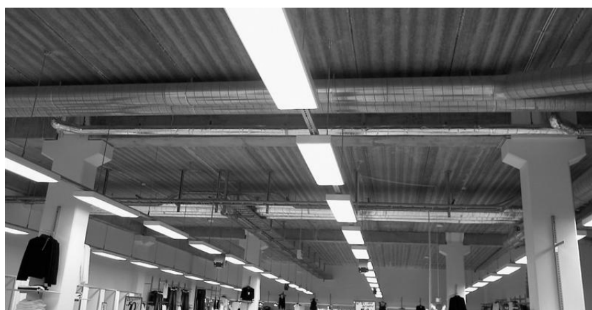
Figur 8-9: Loftkonstruktionen i butikken Cumani i Kennedy Arkaden.
