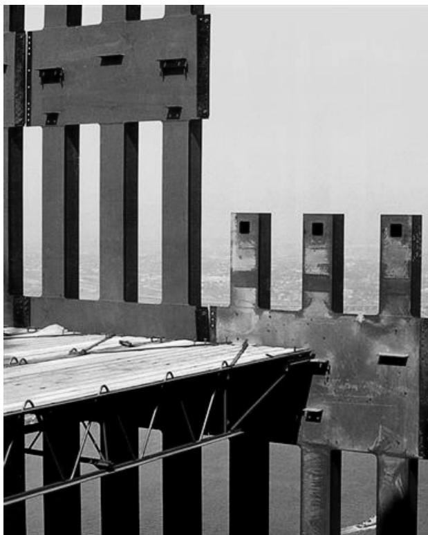
Figur 8-17: Illustration af princippet med stålgitre. [NIST, 2005]
