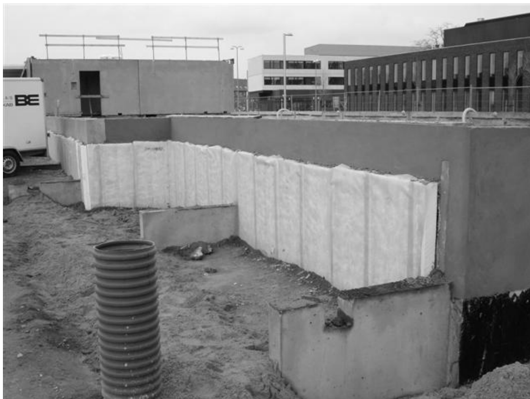
Figur 15-15: Tænkt udformning af kælder, hvor der nederst til højre er et lag asfalt, mens der midt på billedet ses isolering i form af batts.
